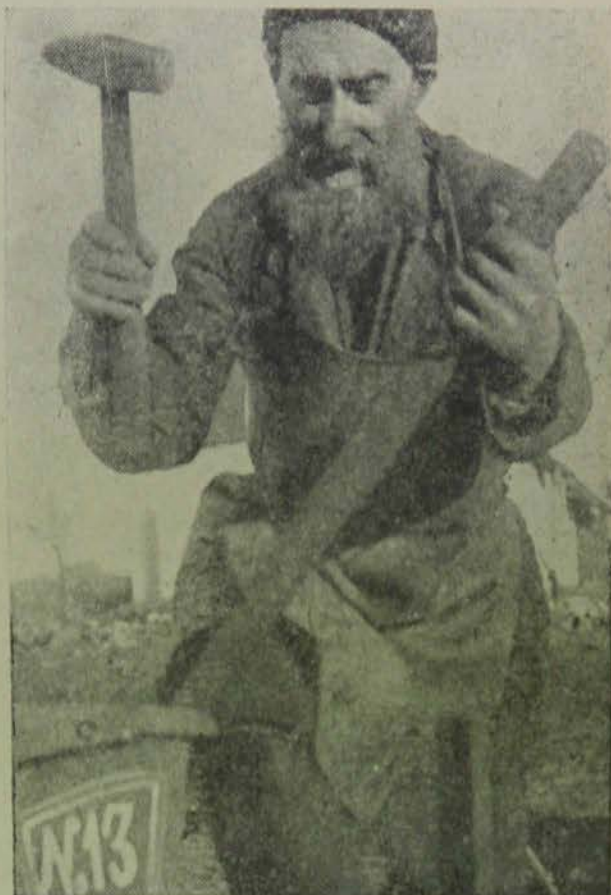
Тов. Каждый, кузнец Ремонт бунера.
