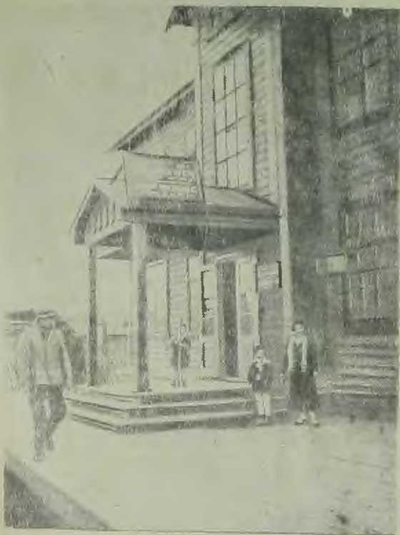
Еврейская автономная область. На сн.: новое здание облсберкасы в г. Биробиджане
