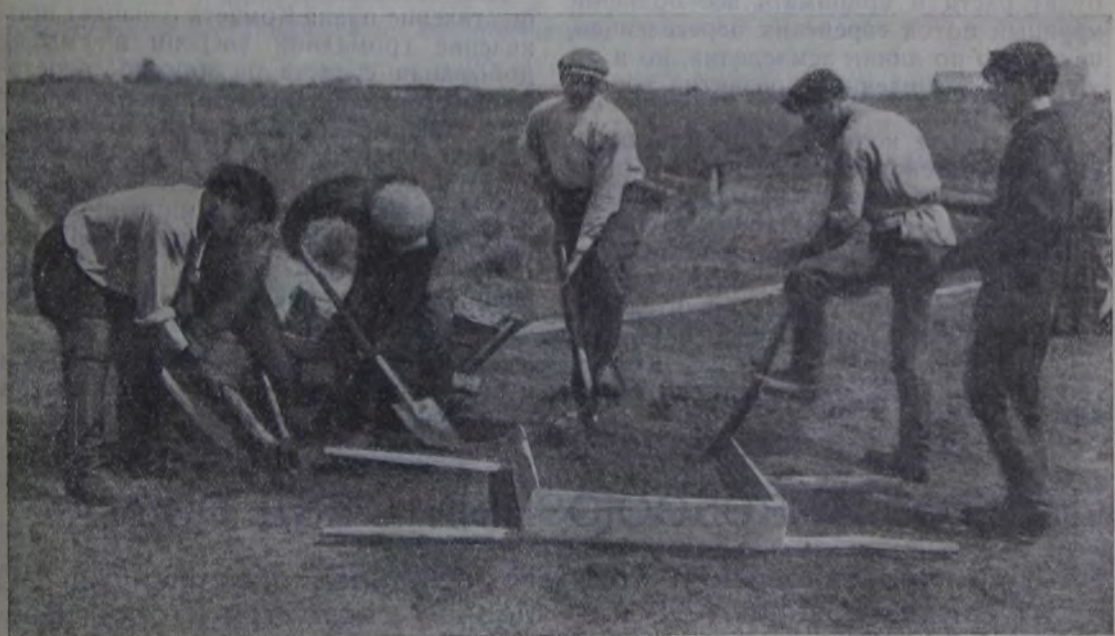
На земляных работах в Биробиджане
