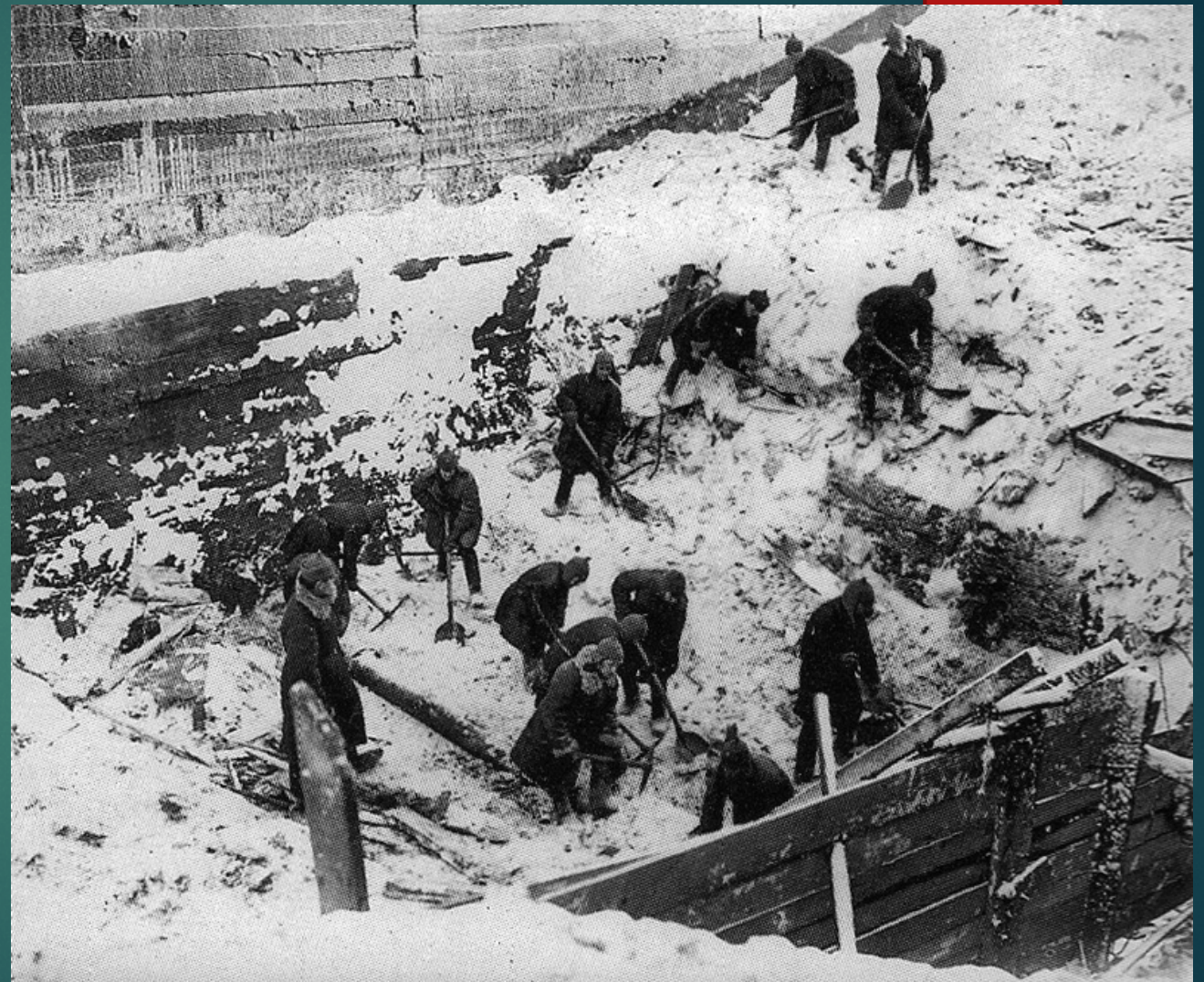
Бойцы ОКДВА на строительстве хабаровской электростанции.
