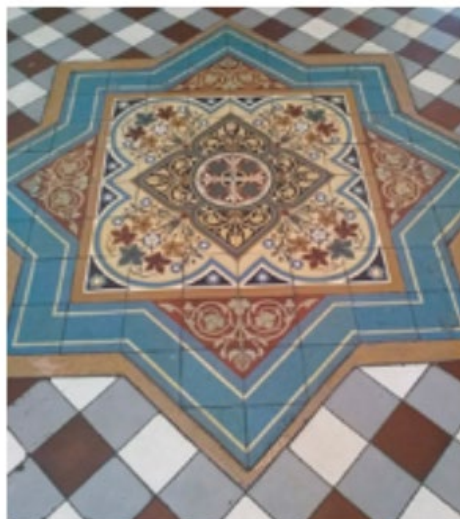
Метлахская плитка в вестибюле библиотеки.
